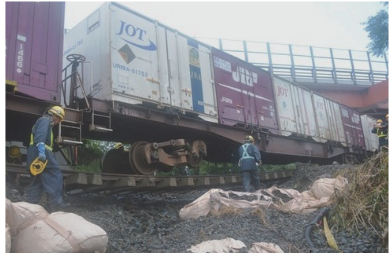
2013年9月19日 函館線貨物列車脱線事故 約270ヶ所で線路異常放置が明らかに
