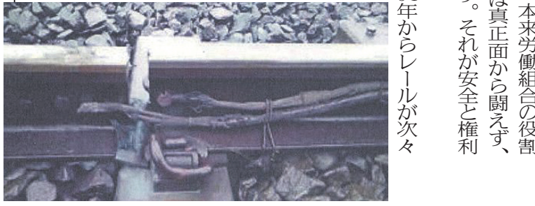
2004年～JR各社でレール破断が続出 (写真は2009年3月4日 京葉線での線路破断)
